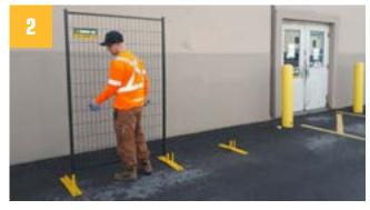
Avec un partenaire, commencer à assembler les panneaux de clôture sur les bases. Insérez d'abord la cheville carrée dans le panneau, puis faites glisser le panneau vers la base précédemment installée et inséez-le sur la cheville ronde. Veuillez noter que toutes nos barrières sont installées avec la plaque Modu-Loc au-dessus et la barre horizontale orientée vers le site.
