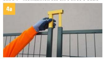
SI VOUS UTILISEZ DES CAPS: Vous êtes maintenant prêt à finaliser la configuration de la barrière en installant les caps. Tous les caps se composent également d'une cheville carrée et d'une cheville ronde. Ceux-ci doivent être installés de la même manière que les bases ont été disposées: la cheville ronde vis-à-vis la cheville ronde et le carré avec le carré. Installez le capuchon dans le haut du panneau, et insérer le cap complètement.
