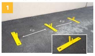
Toutes les bases de clôture Modu-Loc se composent d'une cheville carrée et d'une cheville ronde. Disposez les bases de clôture avec 4 pied d'écart avec tous les ronds face à la direction que vous aller installer votre clôture.
