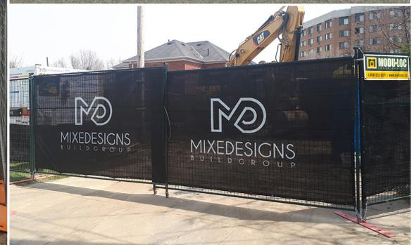
**Les écrans visuels Modu-Loc peuvent être utilisés pour limiter la propagation de la poussière et des débris sur les chantiers de construction, ou limiter la visibilité de certaines zones - comme pour les roulottes de chantier ou les toilettes. Modu-Loc offre maintenant un choix de canevas de marque augmentant la mise en valeur de la marque et les occasions commandites.**
