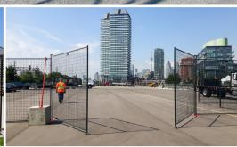
Modu-Loc propose des portes d'accès pour piétons et véhicules qui peuvent êtres installés n'importe où le long d'une clôture pour favoriser un contrôle efficace.
